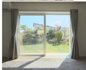
外窓交換（はつり工法）を実施
